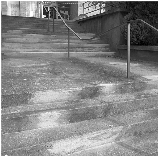
Schody ke zdravotnímu středisku i okolí vchodu do zařízení je opraveno. Skvělé.
