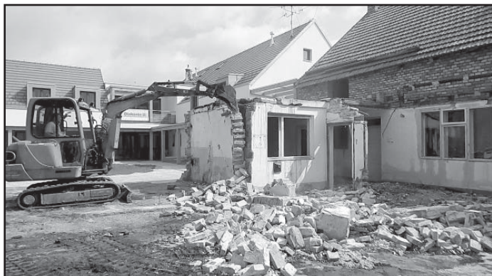
Demolice ve dvoře
