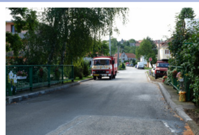
Zrekonstruovaný povrch mostu na ulici Příčná
