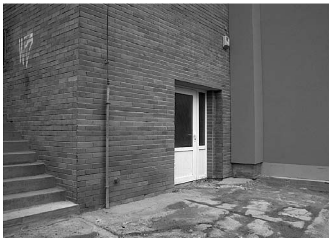
Z parkoviště bude možno použít nově zbudovaný výtah v zadní části budovy zdravotního střediska.
