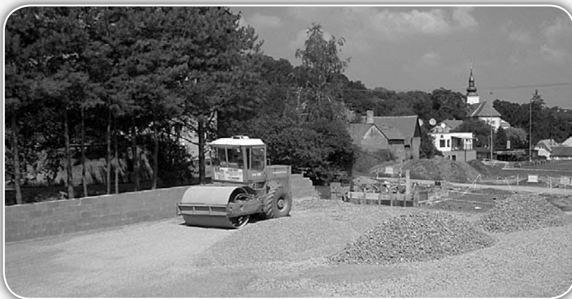
Výstavba víceúčelového hřiště
