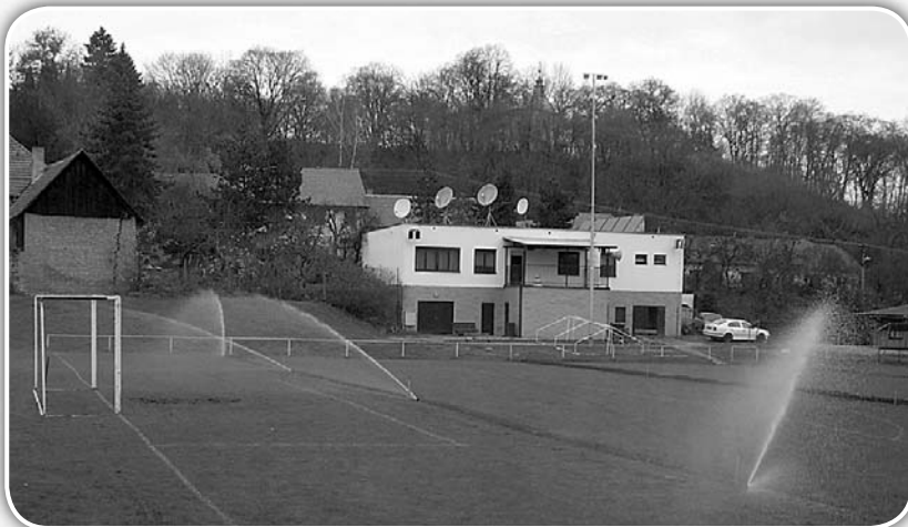
Budování automatické závlahy
